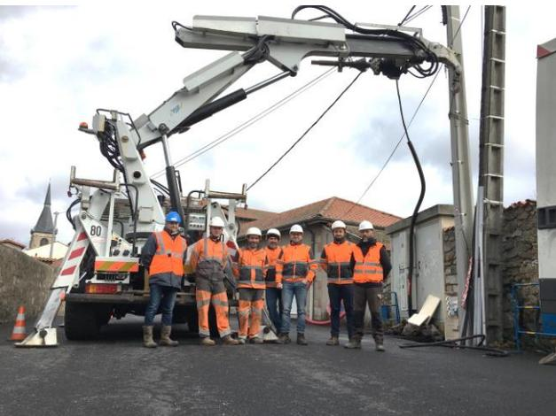
Opération de remplacement d'un support béton à Craponne sur Arzon – Fouille à l'aspiratrice, levage à proximité des ouvrages aériens existants, intégration d'un coffret intermédiaire, reprise du réseau. Equipe Maxime RAUST – Richard GIRAL
