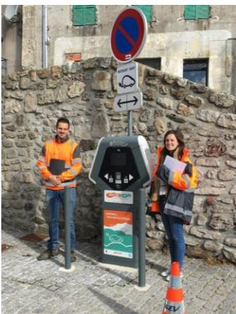
Opération de « bascule » consistant à contrôler le bon fonctionnement de la borne et à l’intégrer à la nouvelle supervision.
