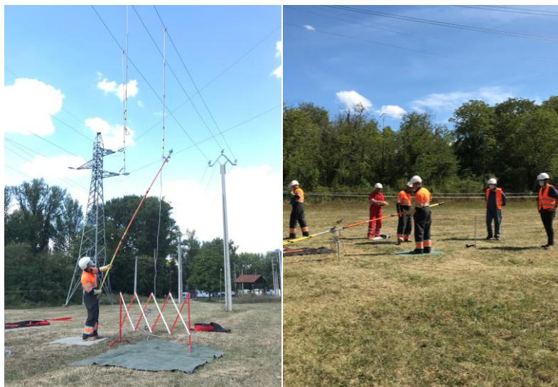
Formation à la consignation HTA sur ligne aérienne nue
