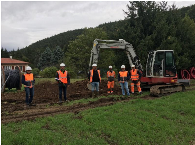
Opération de suppression d'une ligne HTA aérienne, remplacement d'un poste cabine par un poste au sol et reprise du réseau à St Germain Laprade. Equipe Julien SURREL – David LIABEU
