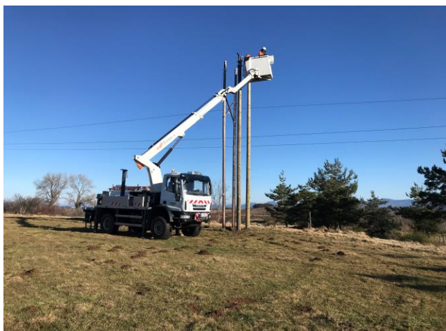
Remplacement d'un portique HTA à CONCIS sur la commune du BRIGNON.
