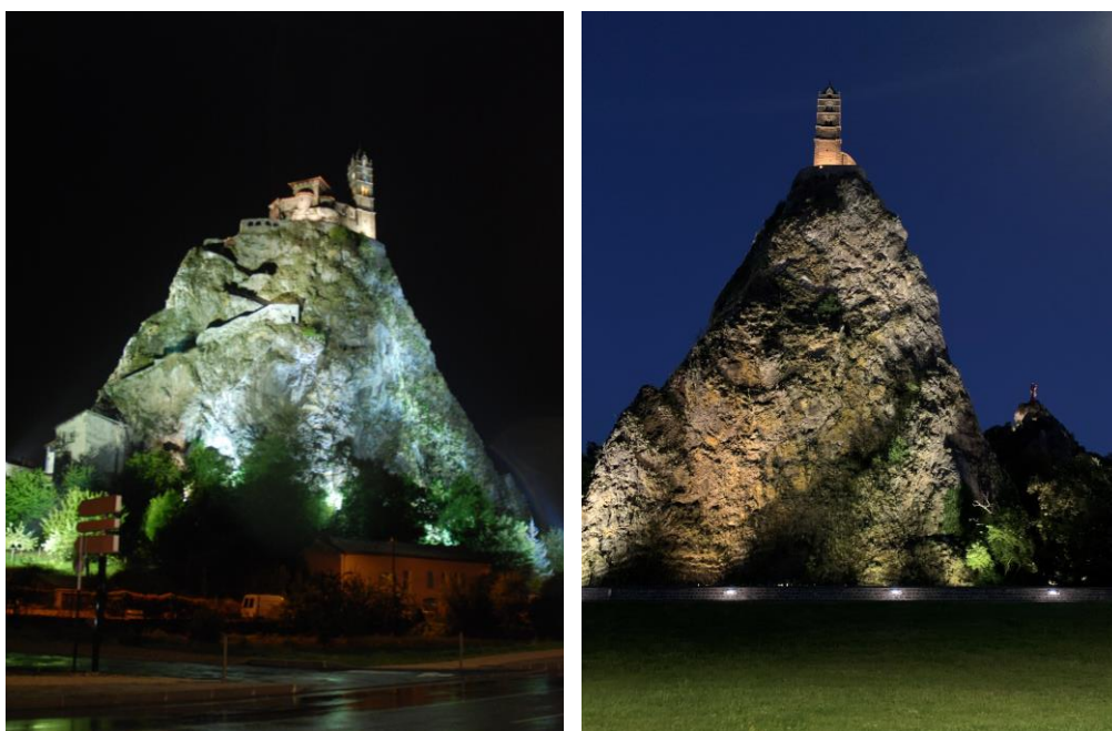
Photos avant et après les travaux
