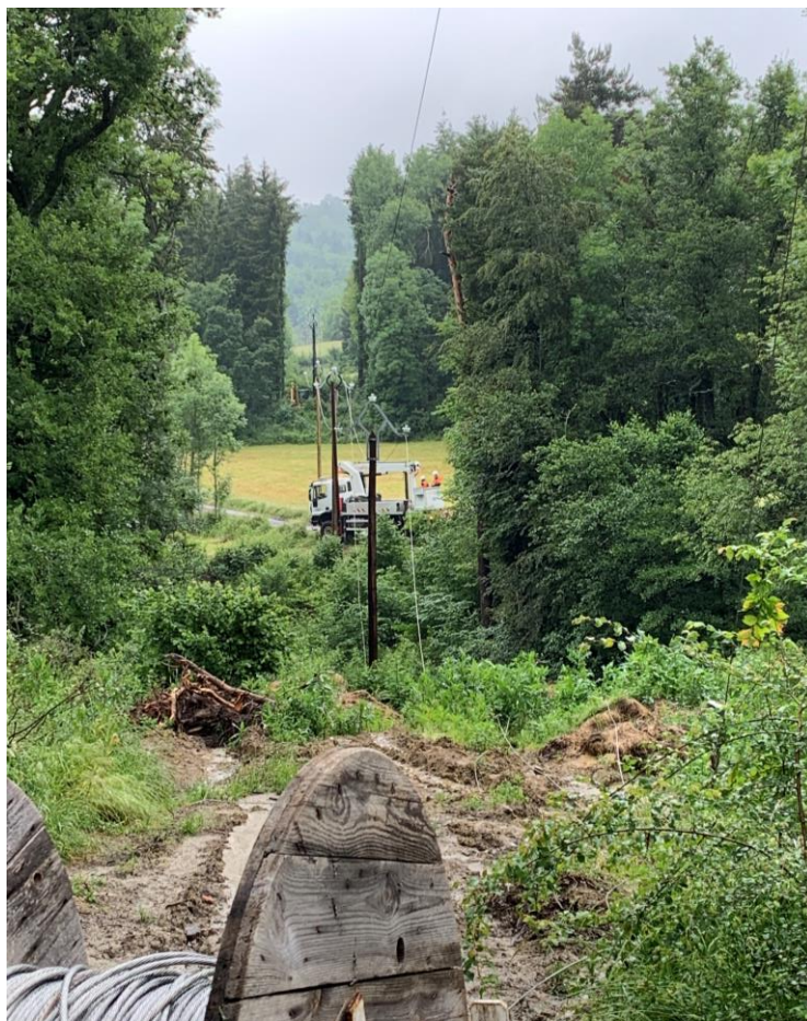
Remplacement de 4 supports HTA à LACHAUD DE ROUGEAC sur la commune de Rosières
