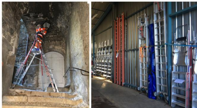
Des groupes de travail se sont fortement impliqués dans la recherche de PIRL et PTRS aujourd'hui à disposition. Quant aux échelles, elles sont consignées et limitées à une utilisation sous processus dérogatoire
