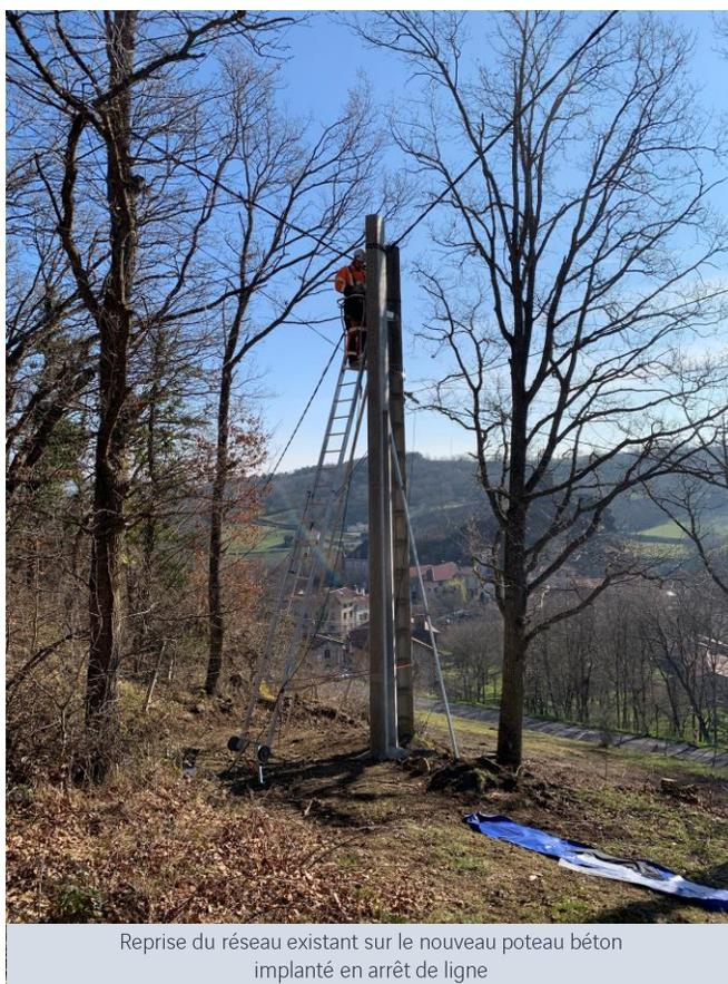
Reprise du réseau existant sur le nouveau poteau béton implanté en arrêt de ligne
