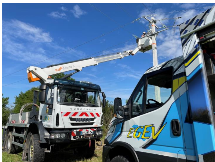
Chantier parfait pour la mise en application des techniques apprises en formation HTA
