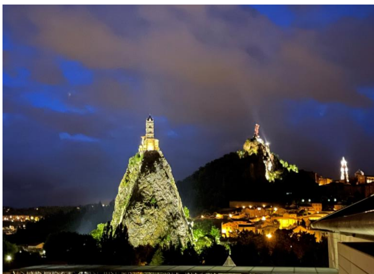
Retrofit complet led pour l'installation de mise en valeur
