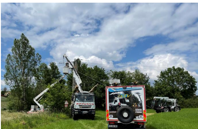
Reprise de non-conformité et remise en tension HTA 116mm 2
